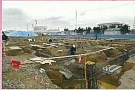
工事の様子H23.11.14
