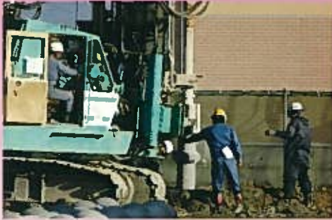
工事の様子H23.10.27
